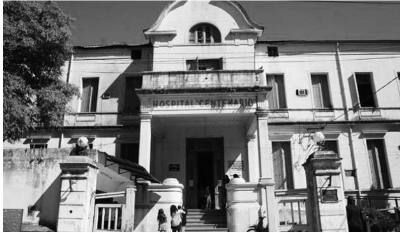
Fachada del Hospital Centenario de Gualeguaychú.
